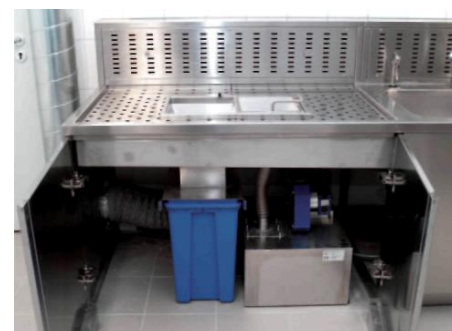
Измельчитель твердой части / 60 л бак с формалиновым насосом с автоматической системой подкачки (индивидуальное решение)
